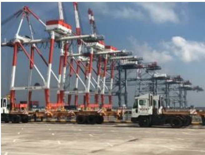
7基の大型クレーンを配備 内3機は追加で設置された
